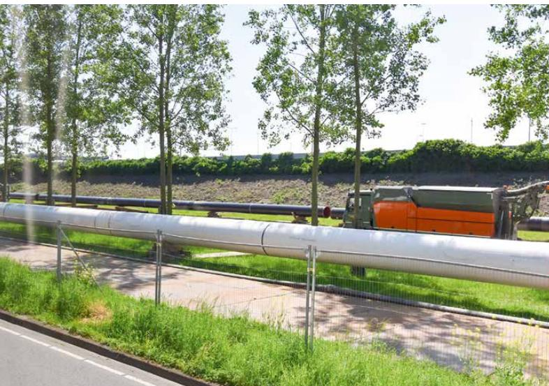
Abb. 4: Die H<sub>2</sub>-Rohre (schwarz) und die CO<sub>2</sub>-Rohre (weiß) liegen mitunter nur 40 cm voneinander entfernt
