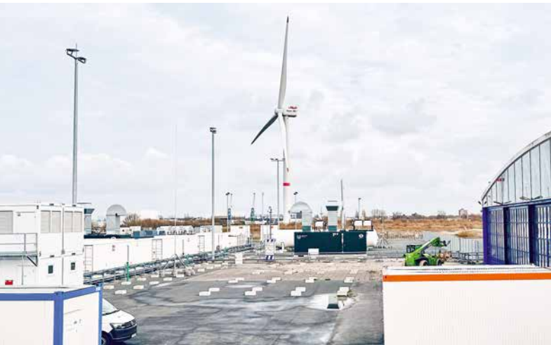
Abb. 3: Blick über das HLB mit freien Stellflächen – links die Leitzentrale [Quelle: Monika Rößiger]
